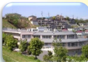
【ヒューマンライフ横浜】 介護老人保健施設
